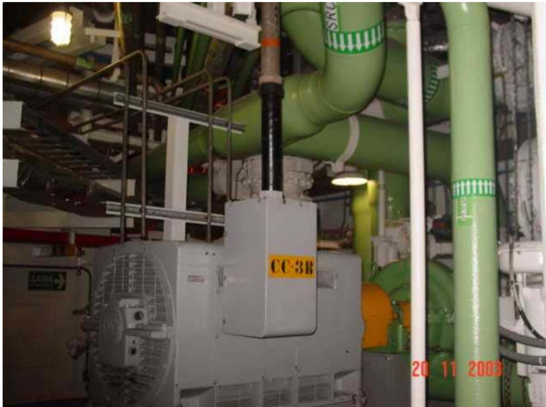
Figura 6 – Motor da Bomba CC-3B do SRC, Elevação – 1,40 do EAN
