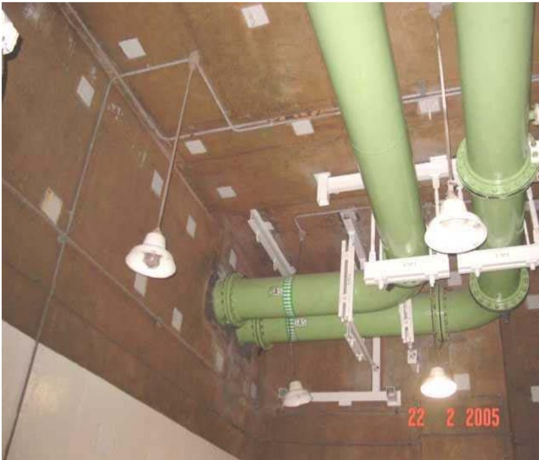
Figura 4 – Tubulações de Entrada e Saída do SAS na Sala dos Trocadores de Calor do SRC, elevação – 1,40 do EAN
