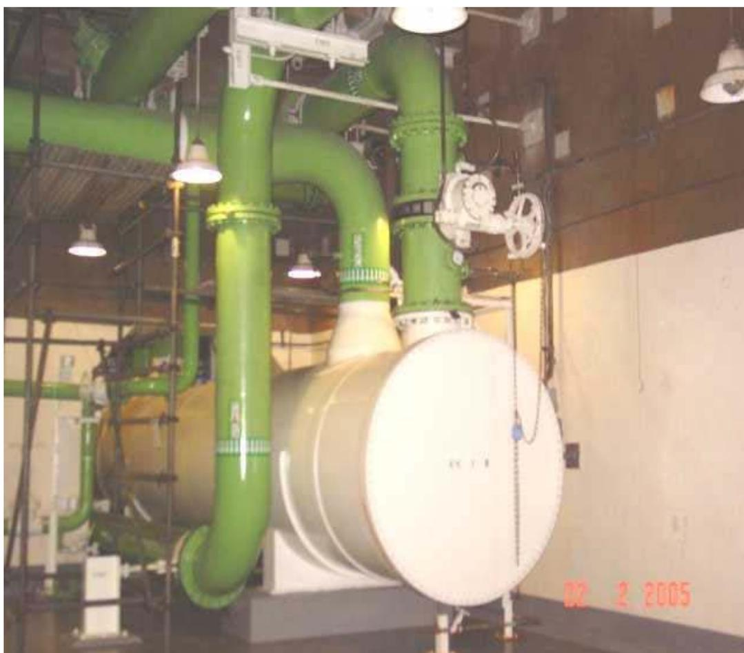
Figura 5 –Trocador de Calor do SRC, Elevação – 1,40 do EAN
