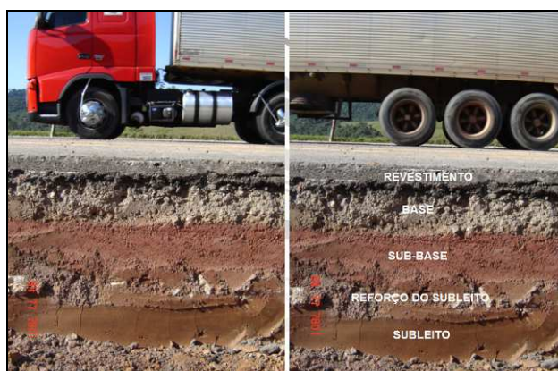
Figura 2.16 (b): Exemplo de uma estrutura típica de pavimento asfáltico rodoviário (Fonte: TONIAL, 2006 - Palestra ABPv).
