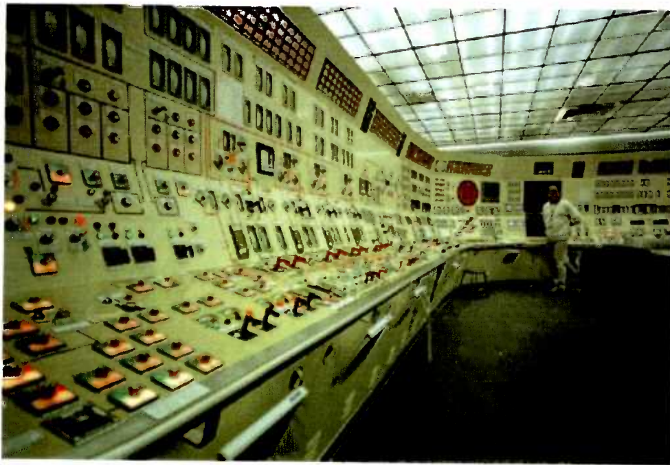
Figura 3.3 – Exemplo de sala de controle que utiliza I & C analógica.
