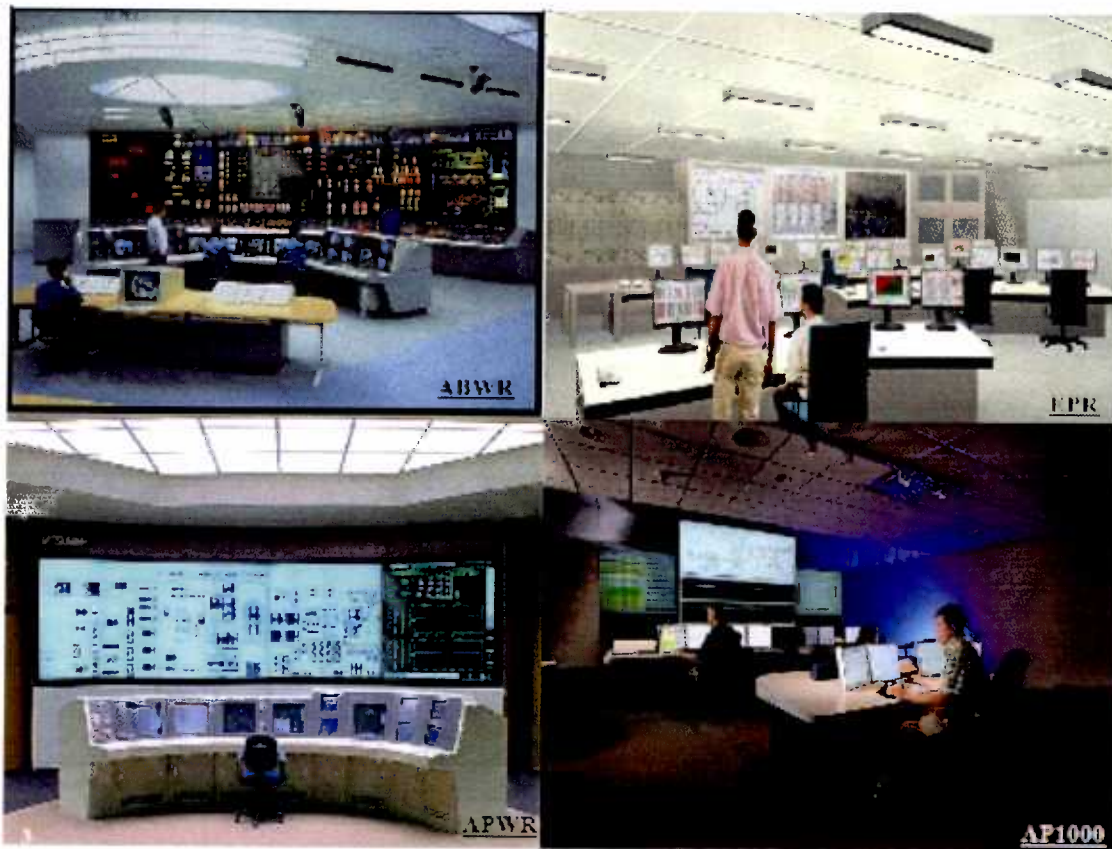
Figura 3.9 – Exemplos de salas de controle que utilizam I & C Digital.
